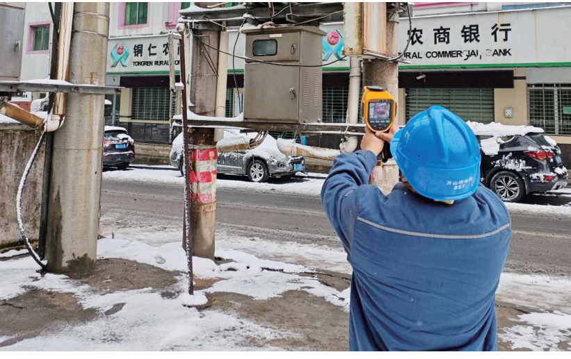
接到降温天气预报后，万山区供电局立即行动，组织人员对易凝冻山区开展重点巡视，确保寒潮天气供电线路安全稳定。 微万山供图
