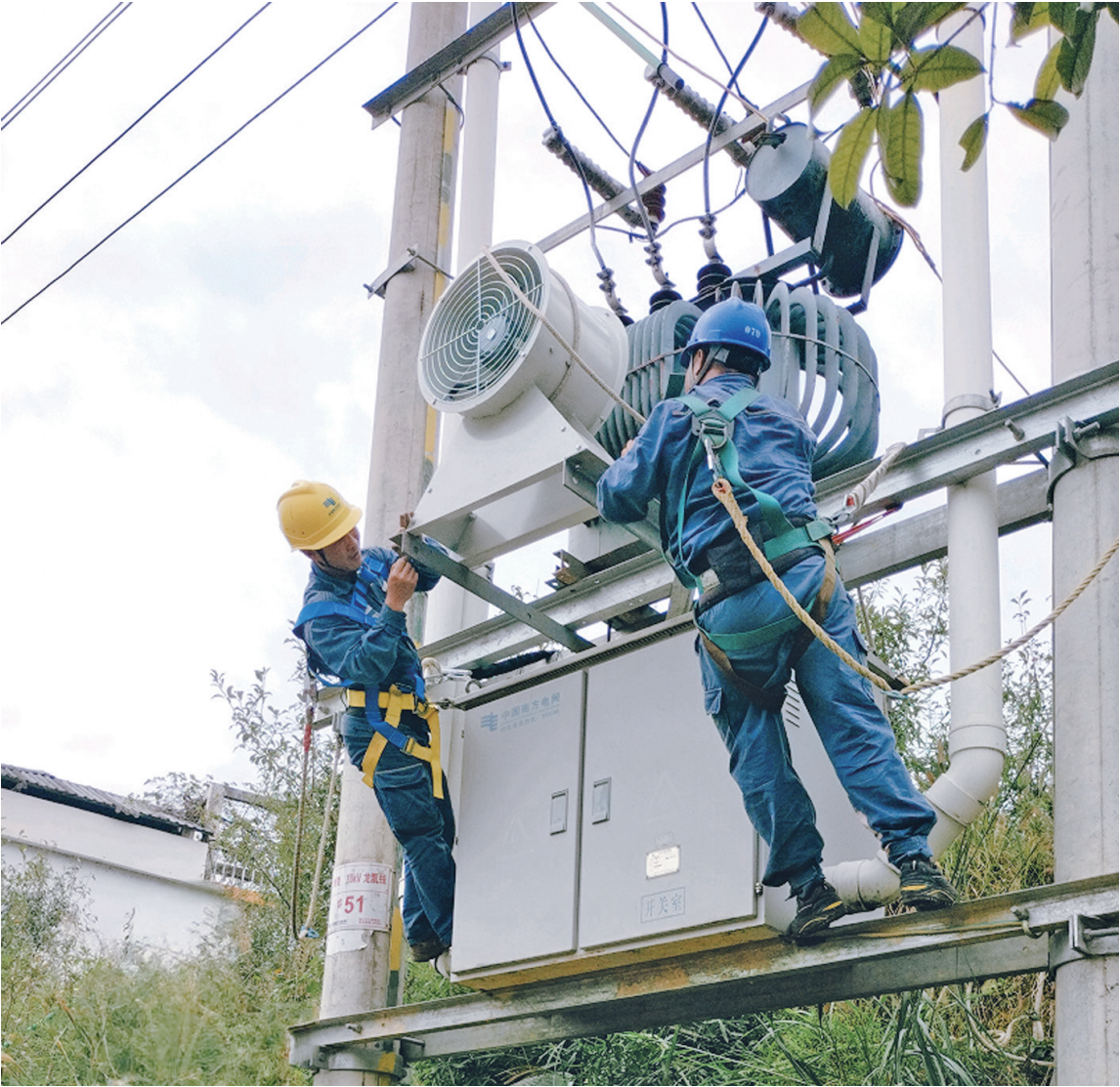
近日，为确保春节安全稳定供电，南方电网江口供电局工作人员在10千伏龙凯线五里桥1号公变进行风机安装工作。 吴瑾 摄
