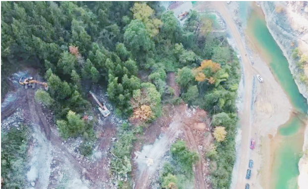
建设中的花滩子水库。
