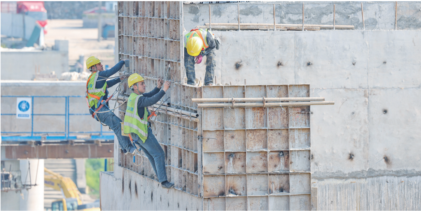
3月24日，工人在玉屏侗族自治县马面坡坝上桥建设工地施工。
