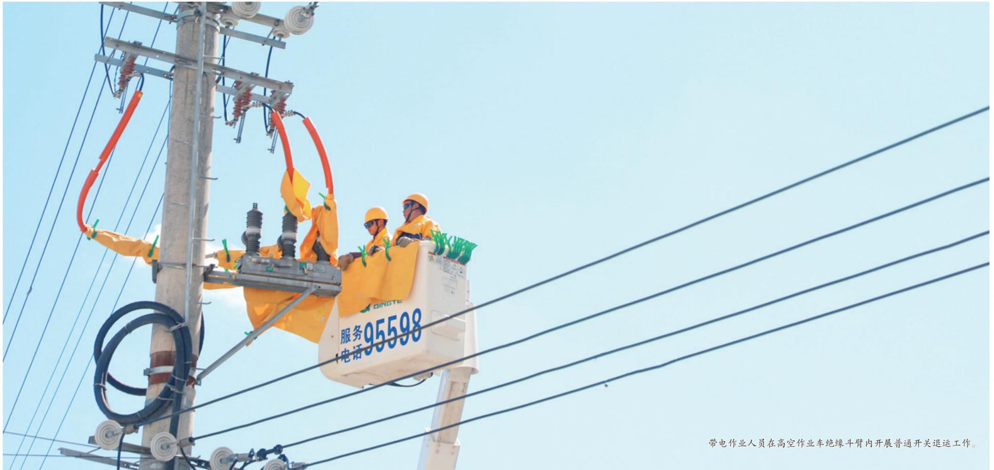
带电作业人员在高空作业车绝缘斗臂内开展普通开关停运工作。
