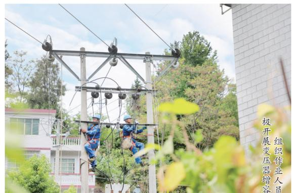
组织作业人员针对重过载、低电压问题积极开展变压器扩容处理。
