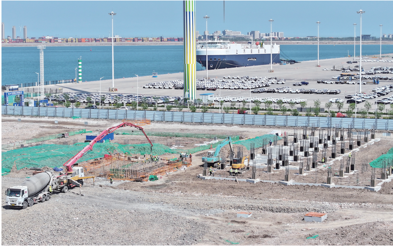
4月25日拍摄的天津港环球滚装码头汽车物流堆场工程建设现场(无人机照片)。
