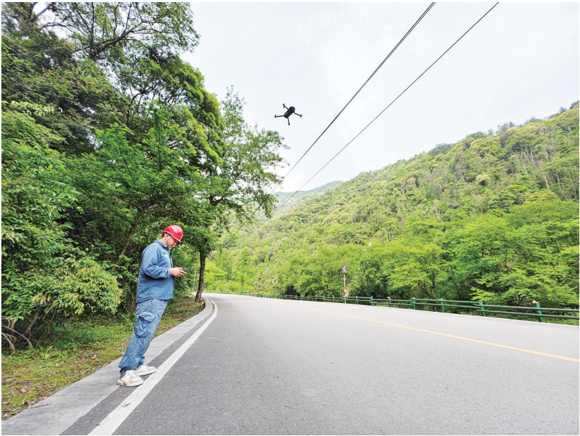
南方电网江口供电局工作人员对梵净山景区内配网线路开展无人机巡视，消除安全隐患，确保“五一”假期用电安全可靠。 吴瑾 摄
