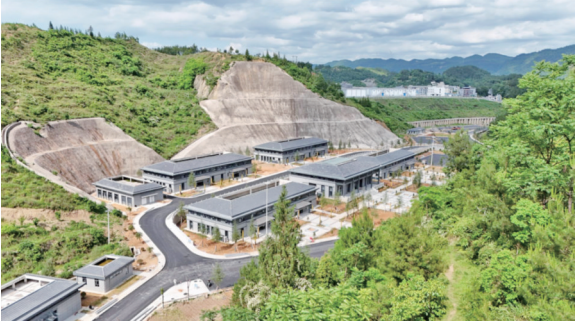
作为石阡县重点民生工程,新建殡仪馆(公墓山)项目目前已在进行设备安装调试和附属设施完善工作,预计将于6月底正式投入使用。 何黔川 摄
