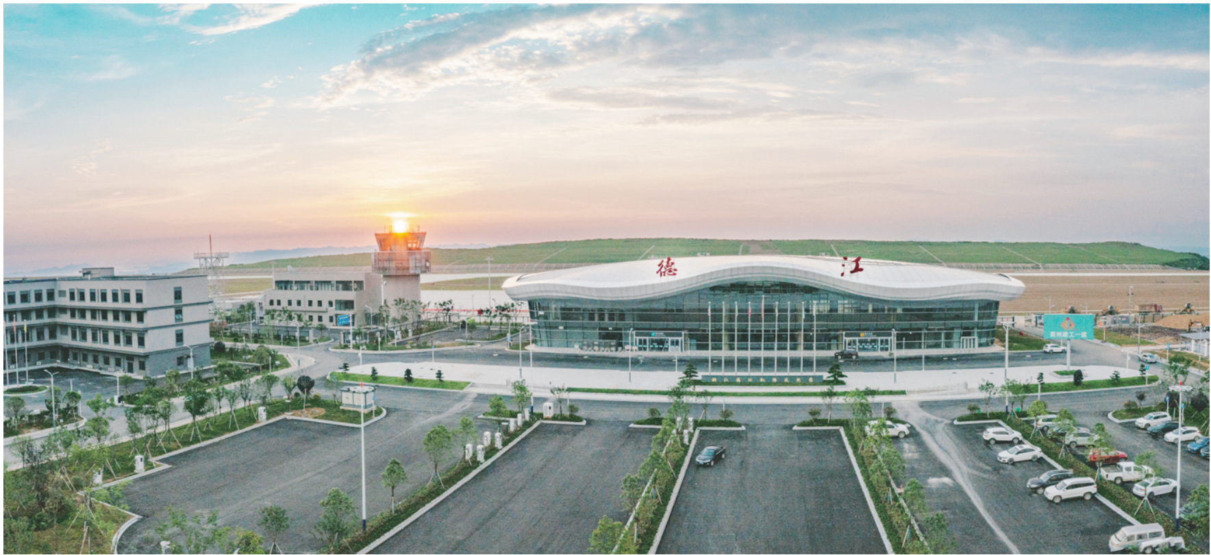
投资21.5亿元的铜仁德江机场项目工程形象进度达100%,飞行区场道工程、助航灯光工程、消防工程、空管工程已全部完成施工。弱电系统进入联调联测阶段,除离港、安检系统外其余系统已调试完成。目前在开展民航基础设施质量管理突出问题专项整治与竣工预验收前自查整改工作。图为7月7日拍摄的铜仁德江机场。
