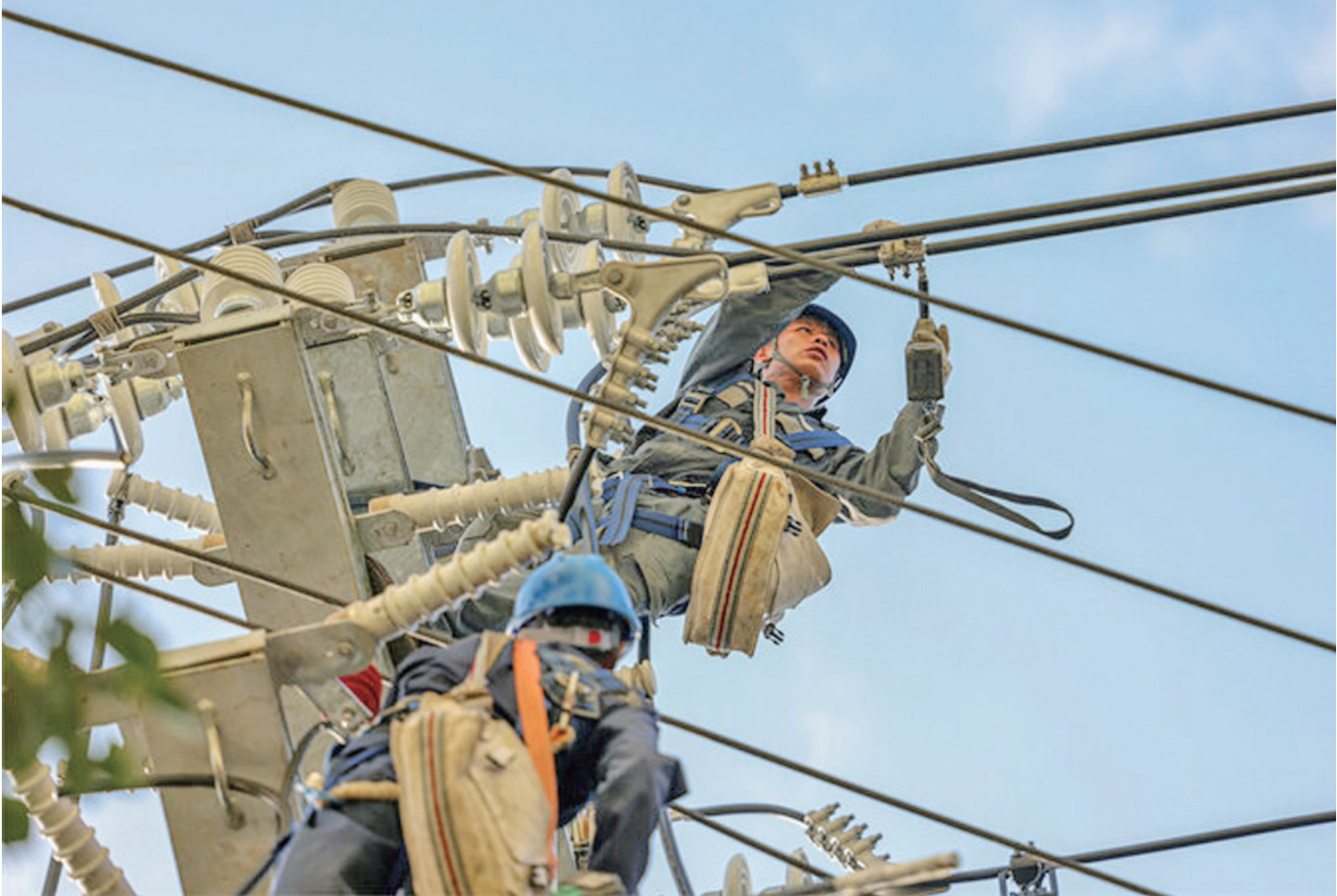
玉屏供电局工作人员对城区老旧电网进行改造。
