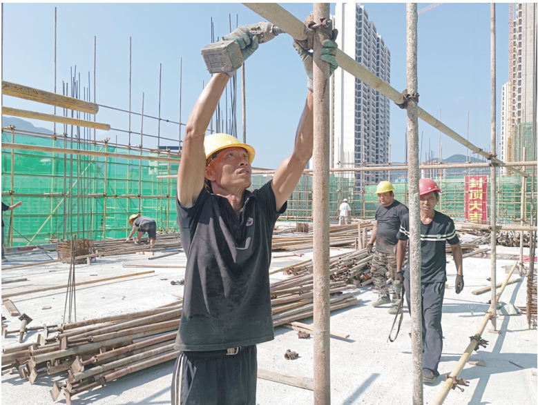
印江二小迁建项目工人加紧施工。张玉莲 摄
