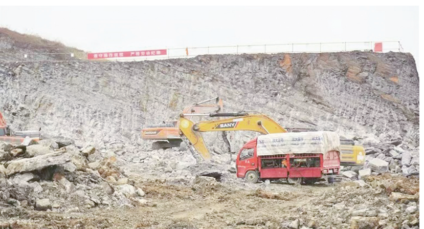
贵州嘉岳矿业有限公司实施的年产50万吨方解石及年产10万吨重晶石、萤石加工生产线项目正加快建设。
