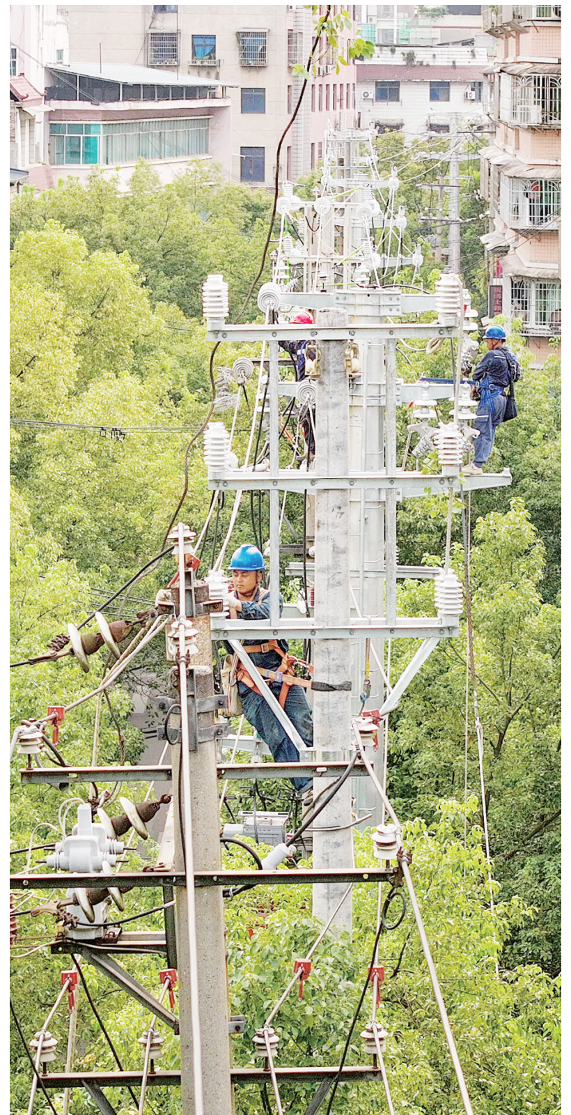
7月19日，玉屏侗族自治县皂角坪街道紫气山社区，南方电网贵州铜仁玉屏供电局工作人员在高温下进行老旧电网改造。胡攀学 车安南 摄
