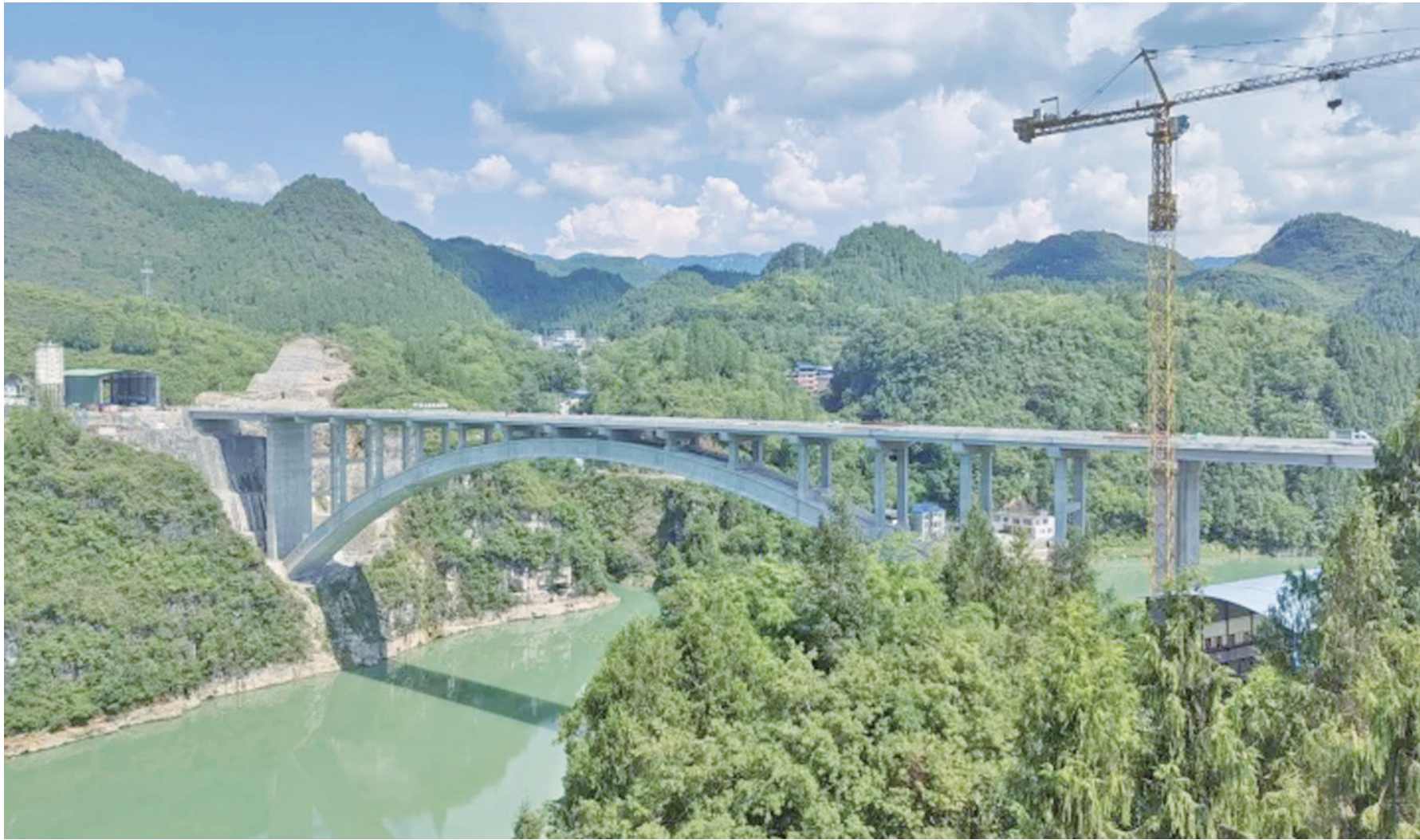
近日,记者走进铜仁夹石特大桥项目施工现场,见到桥面半幅已浇筑混凝土,施工人员正进行桥面铺装层养护、人行道基底清理、桥面钢筋网片和连接公路边沟模板安装作业。据该项目部副工区长罗进介绍,目前正在抢抓工期,大桥整个项目工程预计在8月底全面竣工,9月初进行路面标线。市融媒体中心记者 黄勇 摄
