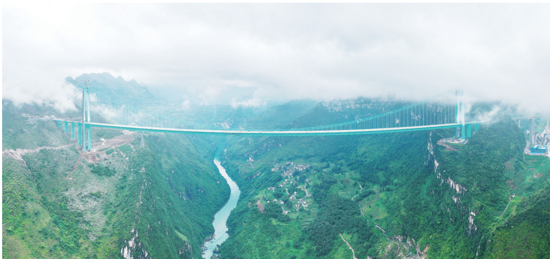
这是8月21日拍摄的贵州花江峡谷大桥。
