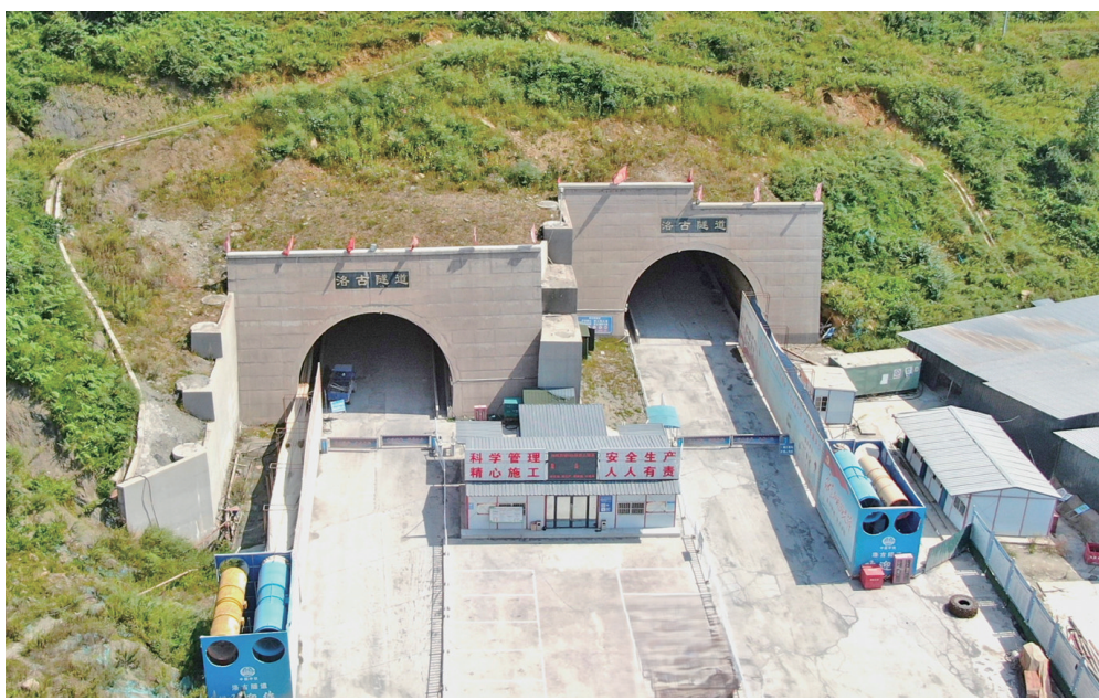
空中俯瞰西昭高速洛古隧道口(8月21日摄,无人机照片)。
