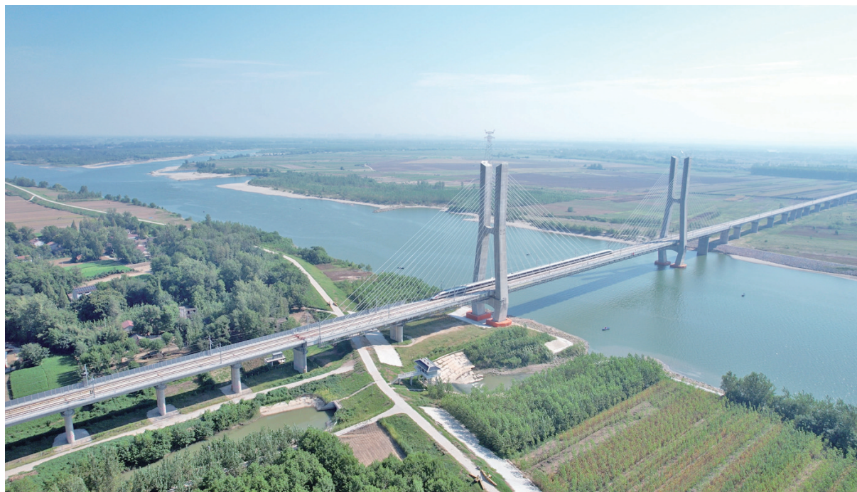
8月26日,55402次试验列车通过沪渝蓉高铁武宜段钟祥汉江特大桥。8月26日,随着55402次试验列车从宜昌北站驶出,沪渝蓉高铁武汉至宜昌段正式进入运行试验阶段。沪渝蓉高铁武宜段起自武汉市,经天门市、荆门市,终至宜昌市,正线全长313公里,设计时速350公里。该段线路于2021年9月开工建设,今年1月完成正线铺轨,5月启动联调联试。新华社发(李奎骏 摄)
