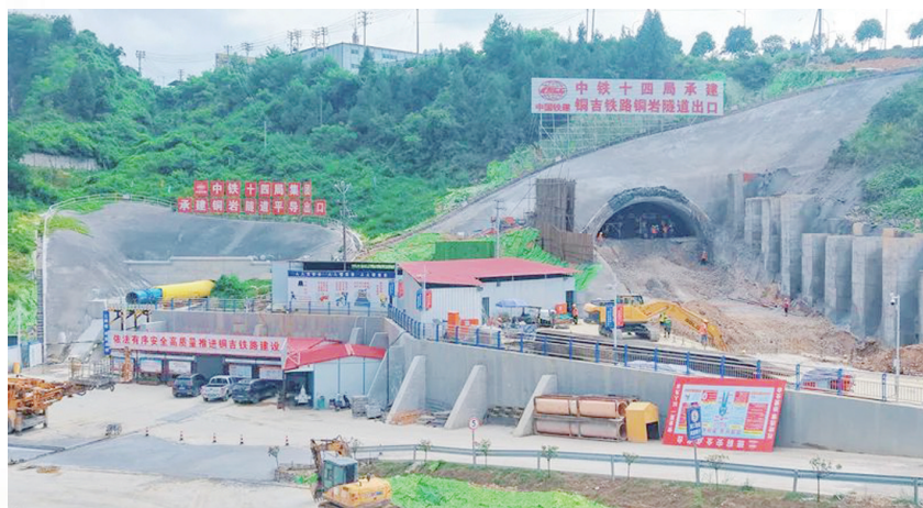
铜吉铁路铜岩隧道项目施工现场。
