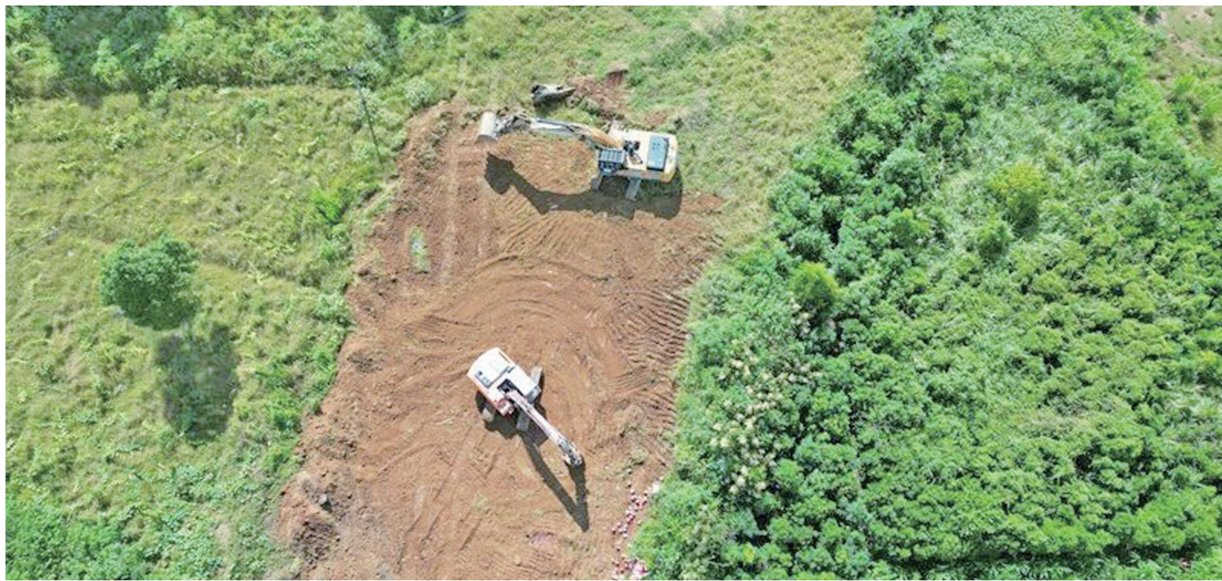
9月12日,位于玉屏侗族自治县田坪镇塘合村的G6512玉天高速公路玉天一标先期动工点正式开工,标志着这条连接湘黔两省的省际交通要道进入实质性建设阶段。
