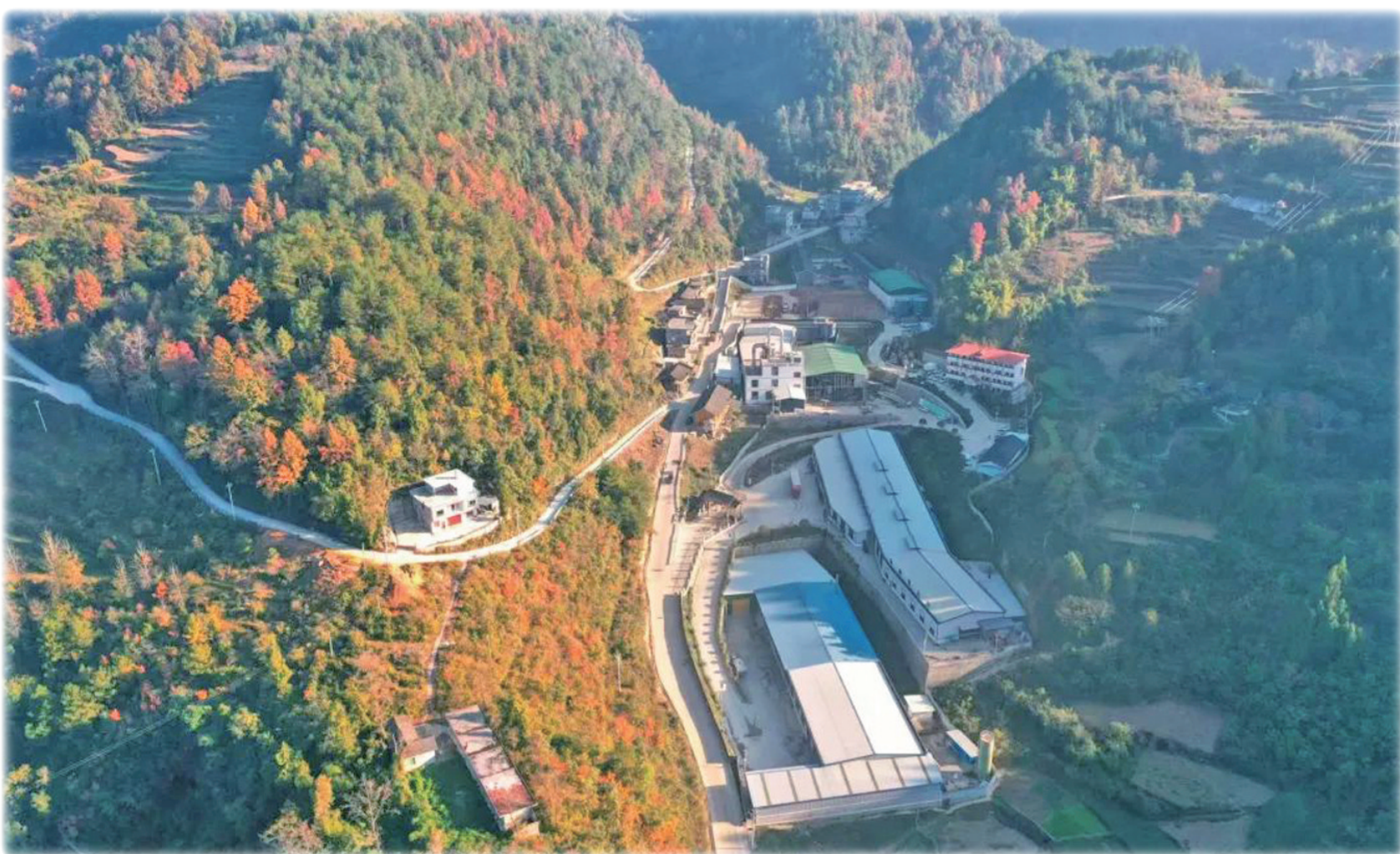
贵州佳里佳公司三道水厂区。
