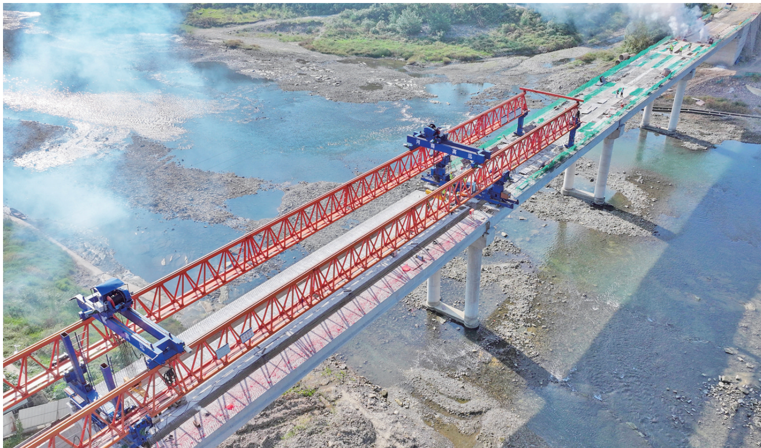
10月9日,玉屏侗族自治县马面坡坝上桥顺利合龙。
