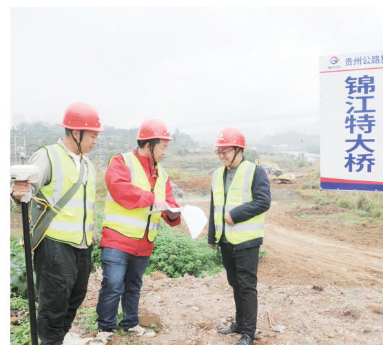
日前,G6512秀从高速公路松桃大兴至万山段TJ-2标段的工人们正在锦江特大桥南北两岸工地上紧张有序地抢抓进度抢工期。 特约记者 蒲召福 摄
