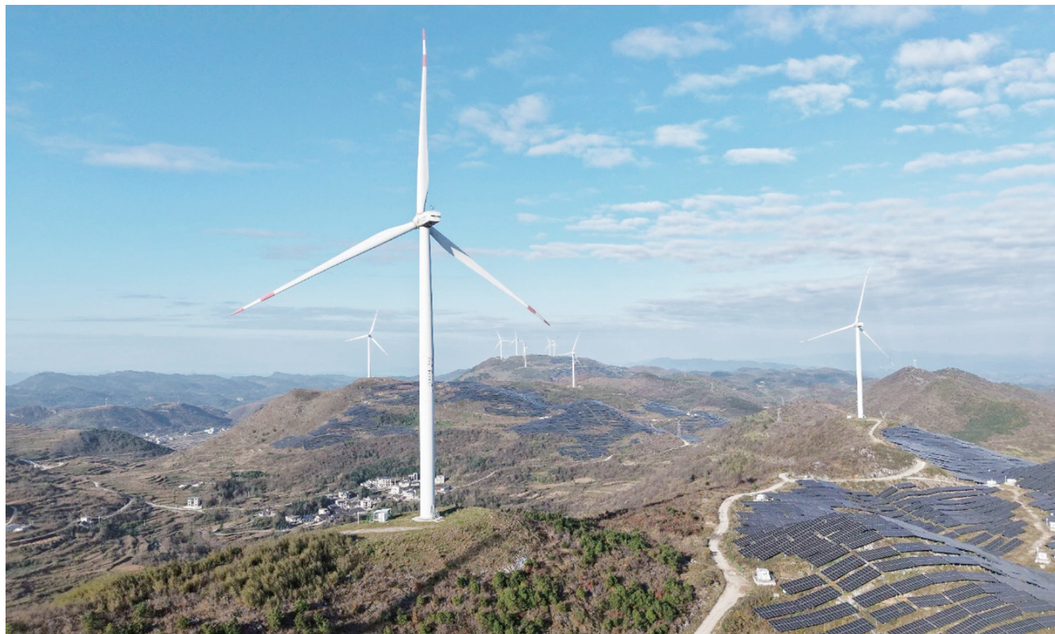
11月12日,在松桃苗族自治县盘石镇,光伏板与风力发电机在群山间和谐运转,构成一幅“风光并举、多能互补”的绿色能源画卷。近年来,松桃自治县坚持走生态保护与绿色发展共赢之路,积极统筹风电、光伏等清洁能源产业布局,构建安全、高效、清洁的现代能源体系,为实现“双碳”目标打下基础。谢慧芳 摄
