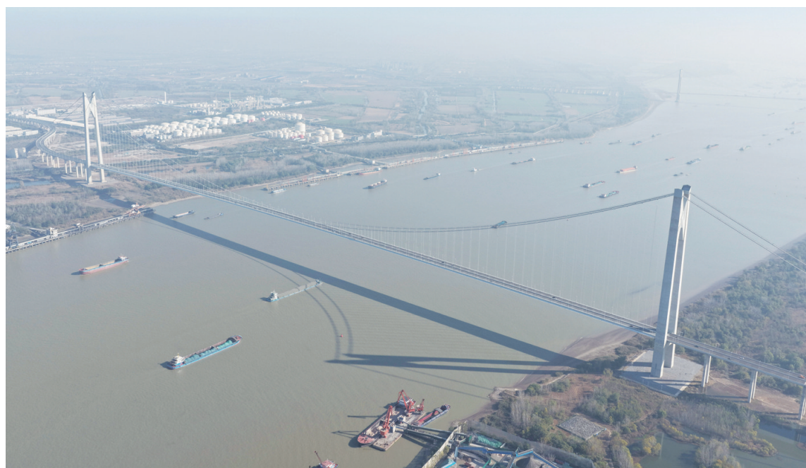
11月26日拍摄的南京新生圩长江大桥(无人机照片)。
