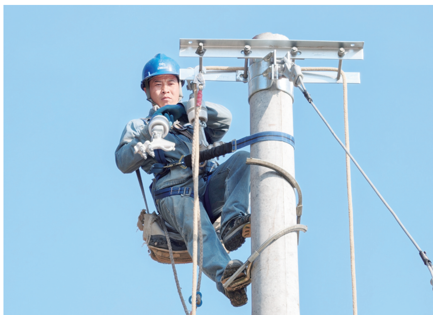
南方电网江口供电局持续推进配网线路升级改造,全力备战迎峰度冬,保障企业生产与群众冬季用电安全可靠。田秋莹 摄
