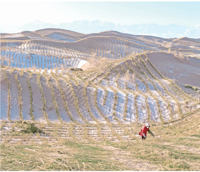
12月13日,施工人员在库姆塔格沙漠铺设沙障(无人机照片)。
