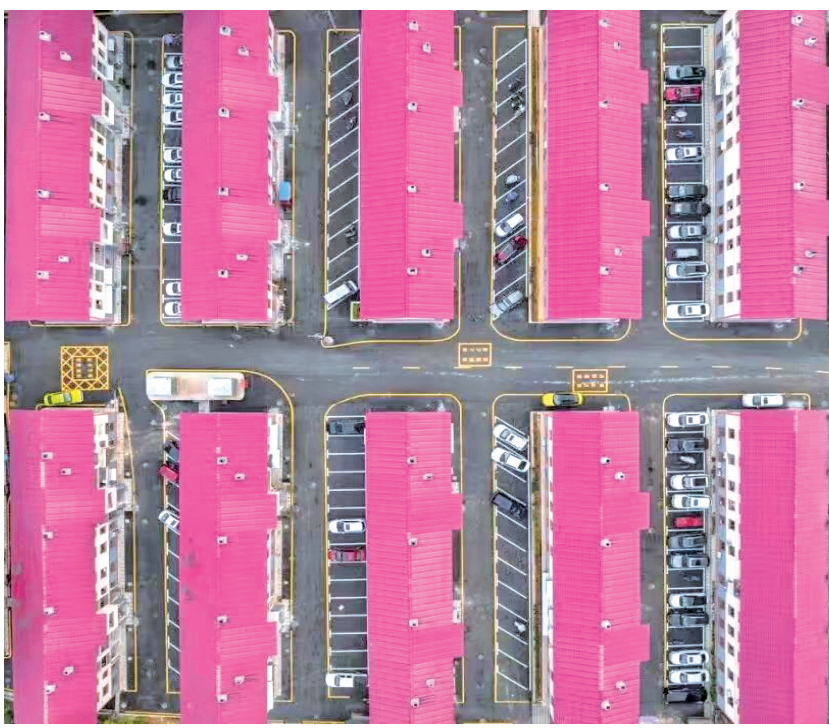
改造后的平溪街铁路老家属区面貌焕然一新。玉屏融媒体中心供图
