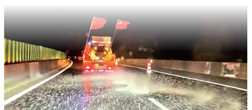
养护站工作人员正在撒融雪剂。
