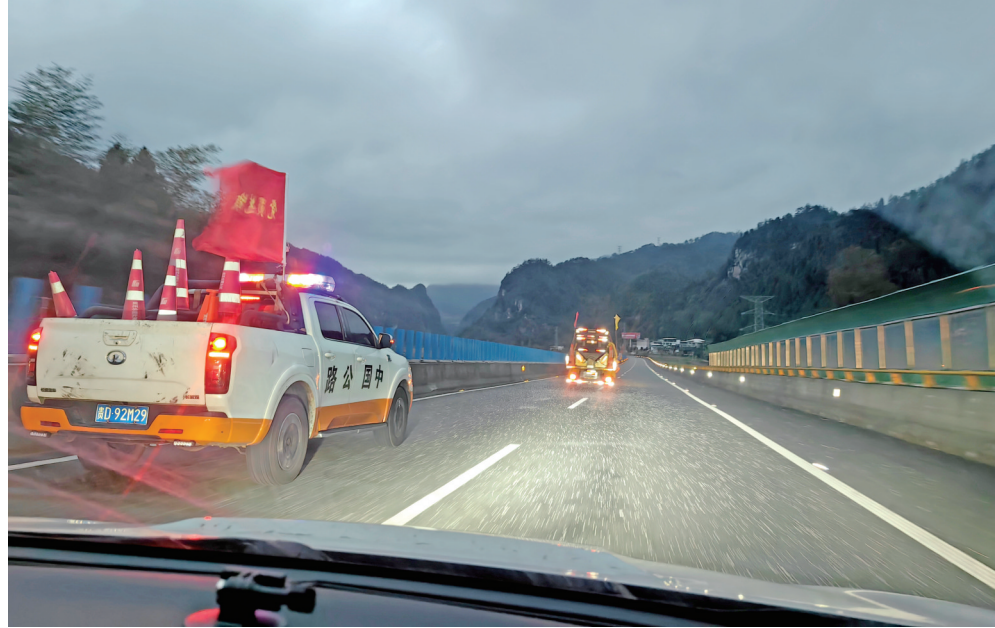
“一路三方”进行除冰作业。
