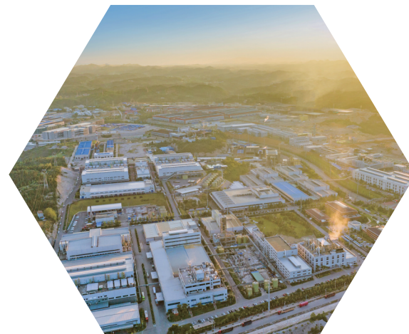
中伟铜仁上市主体产业基地全景。
