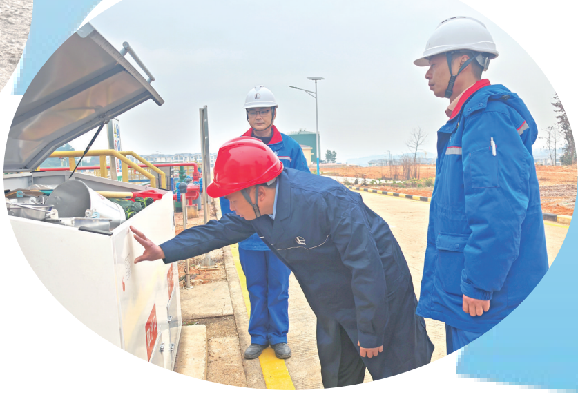
检查大龙油库现场消防物资储备。
