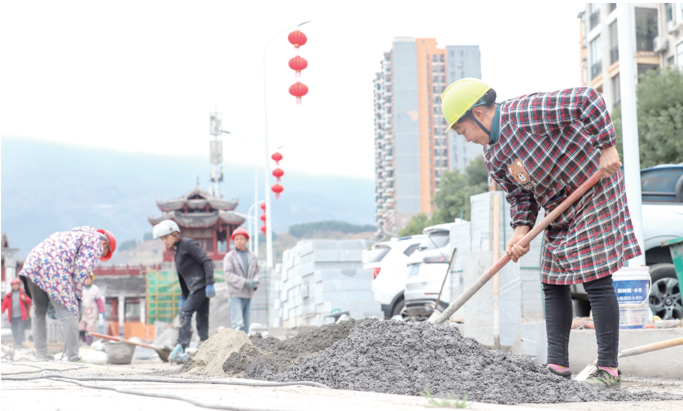
中洲片区地下管网改造工程施工现场,工人们正忙着铺设人行道。
