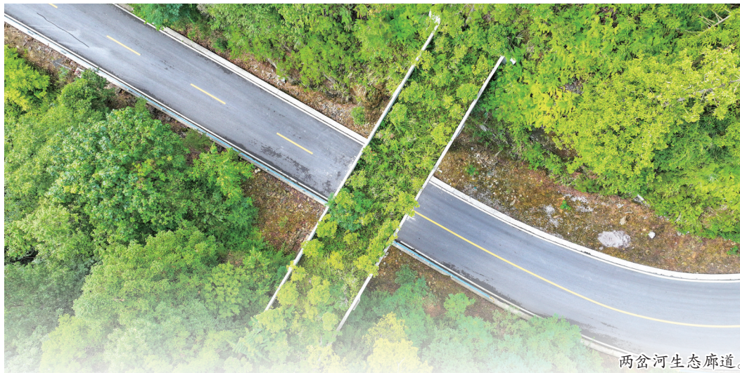
两岔河生态廊道。
