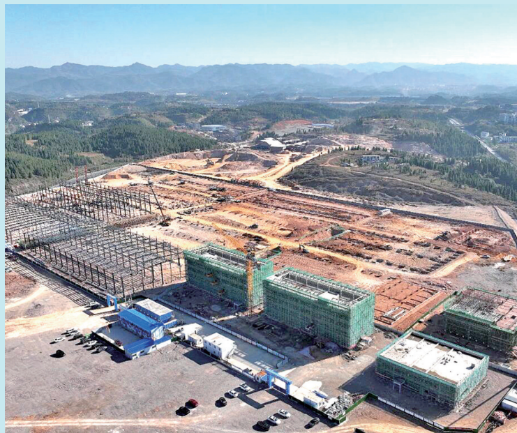
贵州红星电子项目建设现场。
