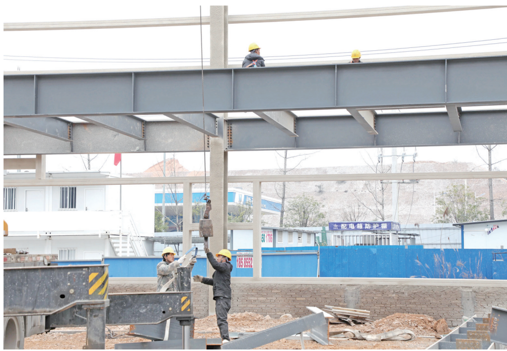
为方能源项目建设现场。
