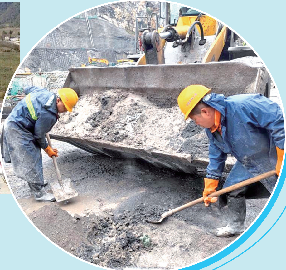
花滩子水库大坝基面清理。
