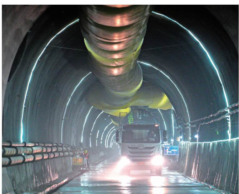
图为工程车正在运输弃渣。
