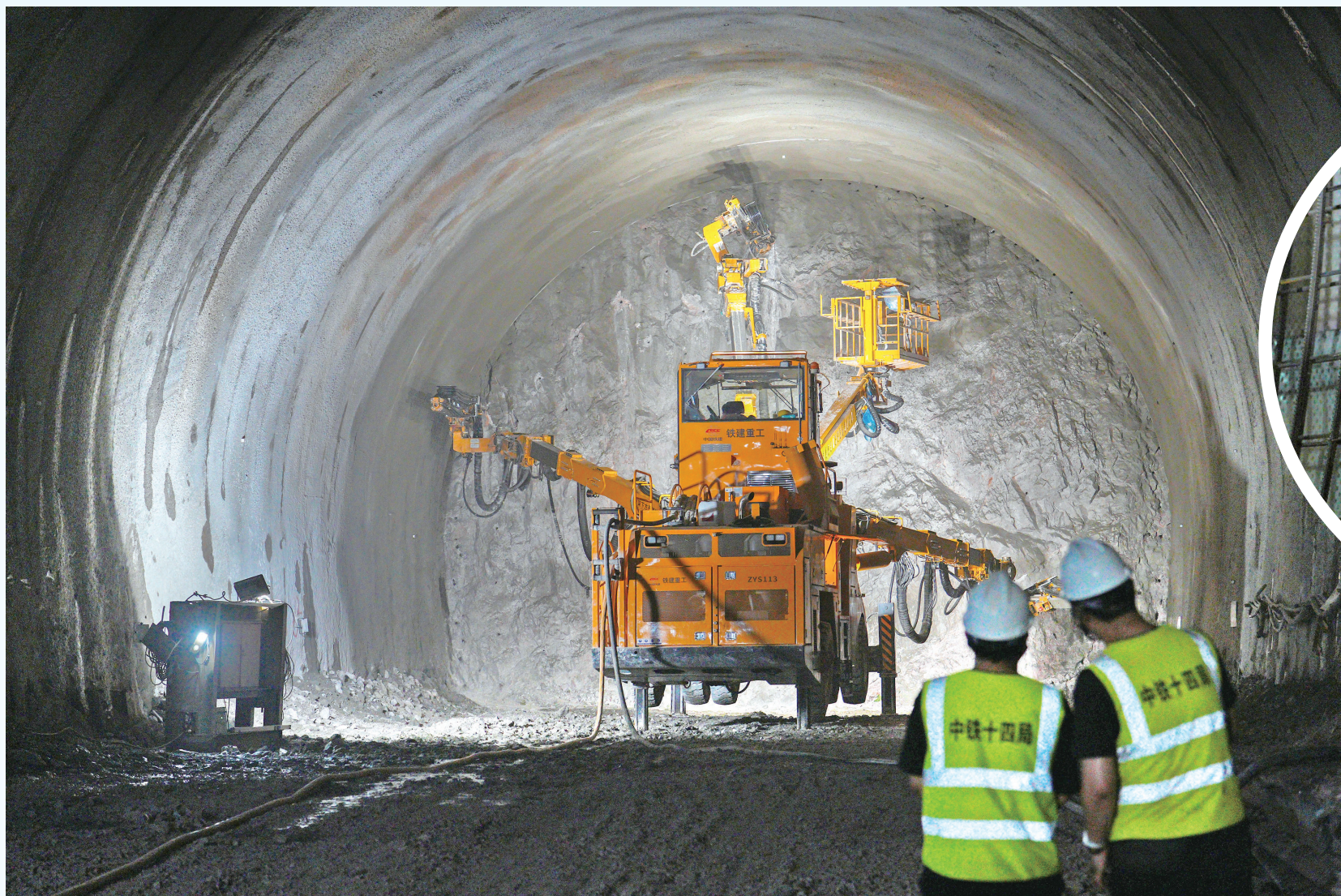
图为两名施工人员正在记录隧道掘进参数。
