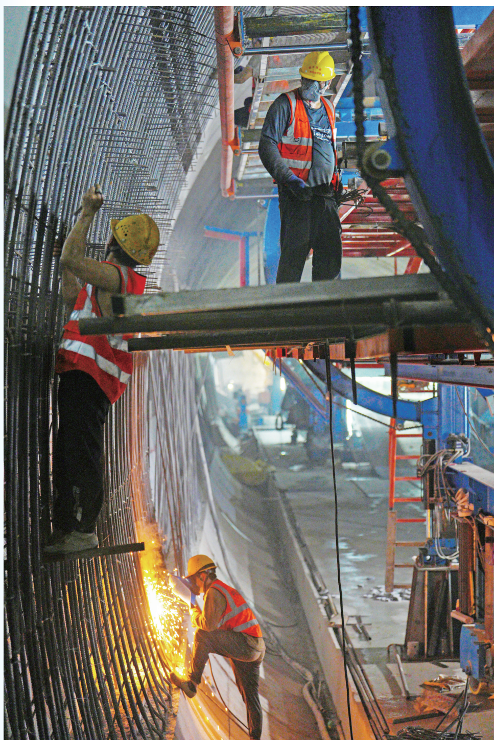
图为工人正在焊接仰拱模架。
