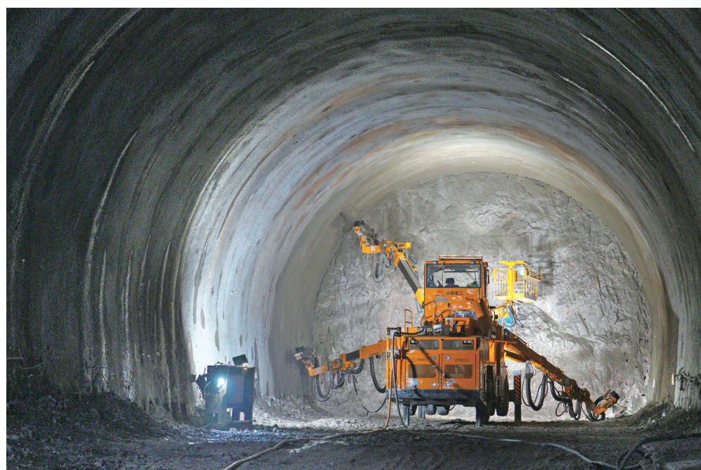
图为三臂凿岩台车正在进行钻孔作业。
