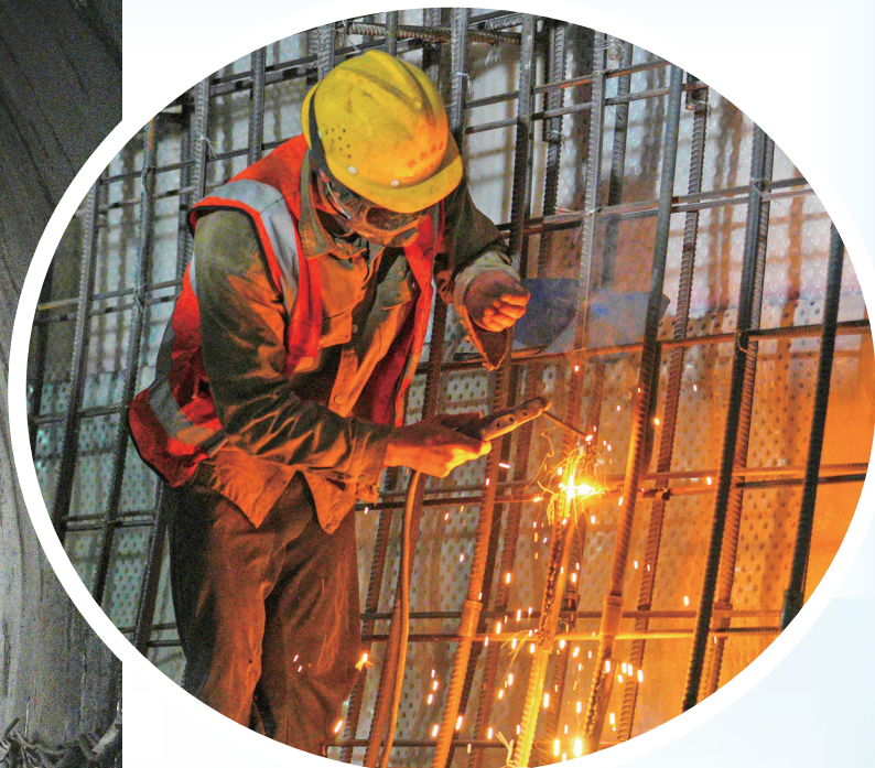
图为工人正在进行焊接仰拱作业。
