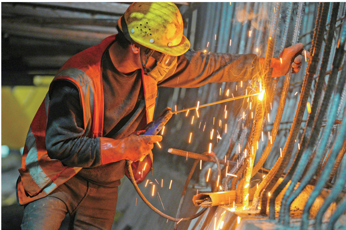
图为工人正在进行焊接仰拱作业。
