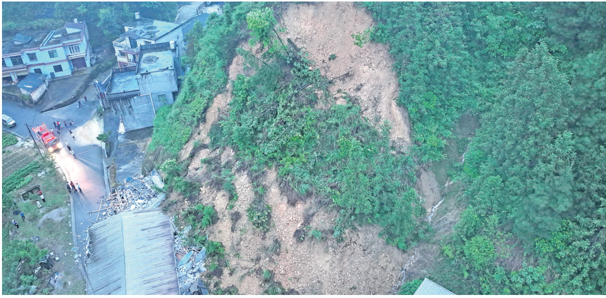
松桃苗族自治县一山体滑坡现场。
