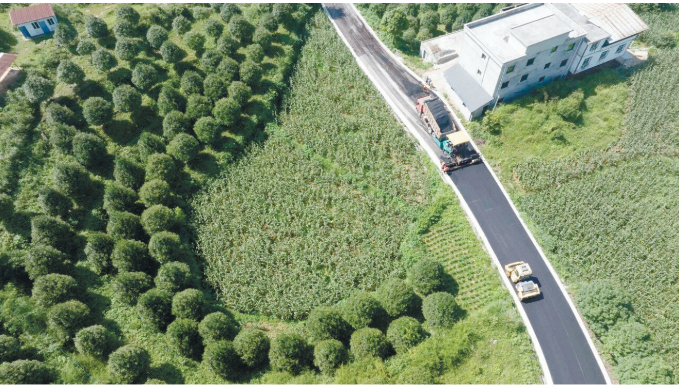
柴山村新寨至黑塘沟路面改造提升项目现场。
