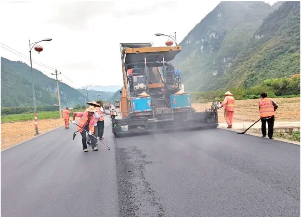
项目施工现场工人正在平整路面。
