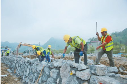
工人们有序推进围墙基础砌筑。
